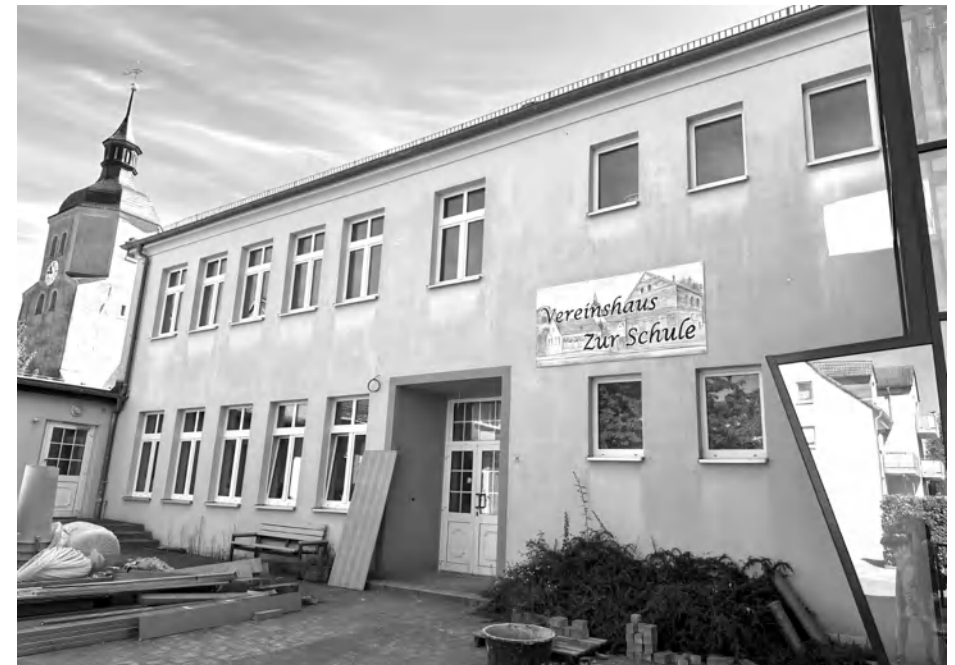
Anfang Juli noch Baustelle – doch im August 2024 wird auch das Vereinshaus „Zur Schule“ neu mit Leben erfüllt. Fotos: Stephanie Bechert
